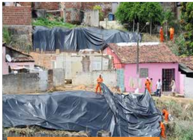
COLOCAÇÃO DE LONAS PLÁSTICAS
