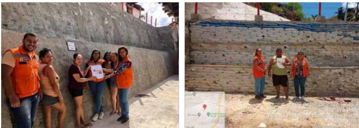
FIGURA 27 – OBRAS PROGRAMA PARCERIA
