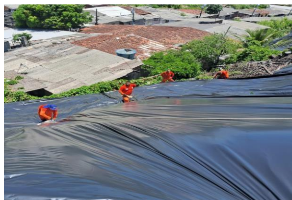
COLOCAÇÃO DE LONAS PLÁSTICAS
