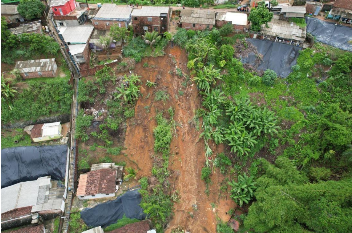
FIGURA 10 - DESLIZAMENTOS DE GRANDE PORTE RECIFE 2025.
