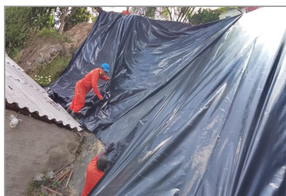
COLOCAÇÃO DE LONAS PLÁSTICAS
